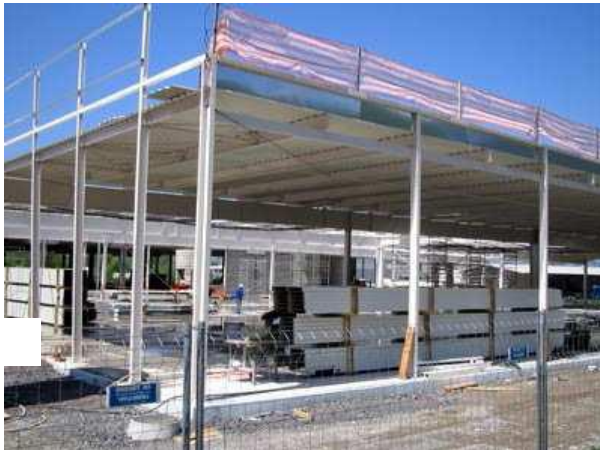
Rohbau – Beton – Stahlkonstruktion
